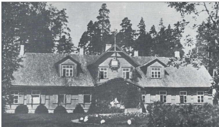
5. attēls. Vīciema Meža skola 1920.–1925. g. (foto: Blankenburgs, 1986). Figure 5. Vīciems Forest School 1920–1925 (photo: Blankenburgs, 1986).
