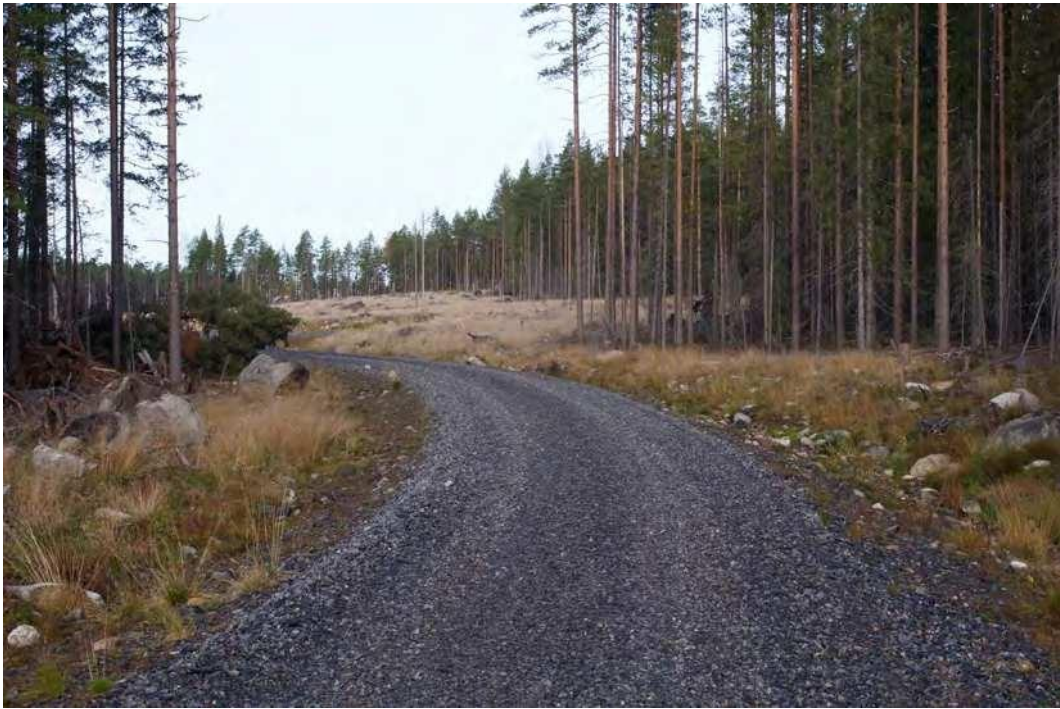
18. att. Meža ceļa būve ir nepieciešama, piemēram, ja blakus esošajos nogabalos drīz paredzēta mežizstrāde. Sākotnējo meža ceļu izvietojumu var plānot, izmantojot mitro vietu kartes. Foto: E. Ring
