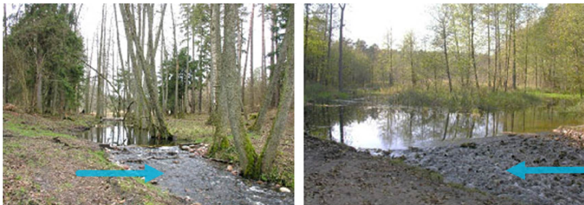
26. attēls. Sliekšņi ar zivju ceļiem (“dabai tuva” konstrukcija). Tiem ir rupja virsma, un tie izvietoti šķērsām visam upes platumam ar iespējami lēzenu slīpumu, lai kompensētu līmeņu starpību. Foto: Andrzej Ryś.
