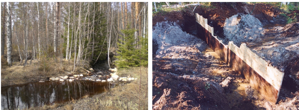
6. attēls. Kreisajā pusē gultnes dambis darbībā. Foto: Leena Finér. Labajā pusē atbalsta sienas konstrukcijas process: tā tiek novietota gultnes dambja vidusdaļā, kur paredzams vislielākais ūdens plūsmas ātrums. Foto: Matti Seppälä.
