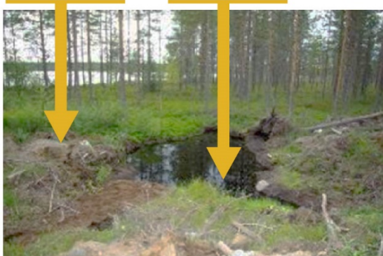
16. attēls. Jauns dakšveidā (Y) izrakts grāvis, kas paredzēts ūdens plūsmas novadīšanai uz virszemes filtrācijas platību Somijā (pa kreisi) un nefīrta grāvja daļa (pa labi). Foto: Eva Ring.
