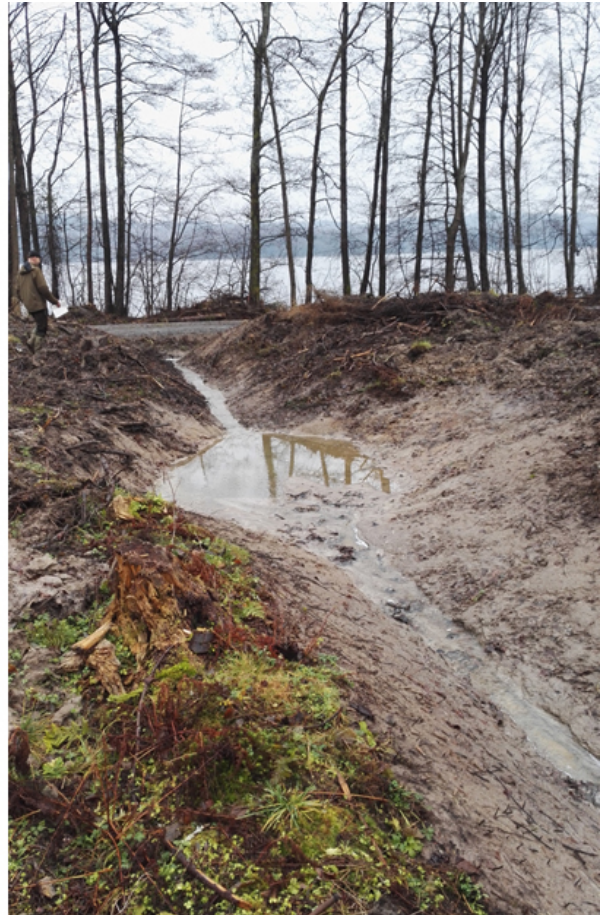
4. attēls. Sedimentācijas bedrītes meliorācijas grāvjos Zviedrijas dienvidu daļā. Foto: Eva Ring (pa kreisi) un Anja Lomander (pa labi).
