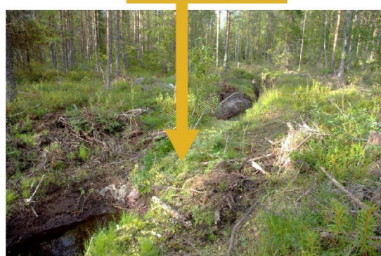
16. attēls. Jauns dakšveidā (Y) izrakts grāvis, kas paredzēts ūdens plūsmas novadīšanai uz virszemes filtrācijas platību Somijā (pa kreisi) un nefīrta grāvja daļa (pa labi). Foto: Eva Ring.
