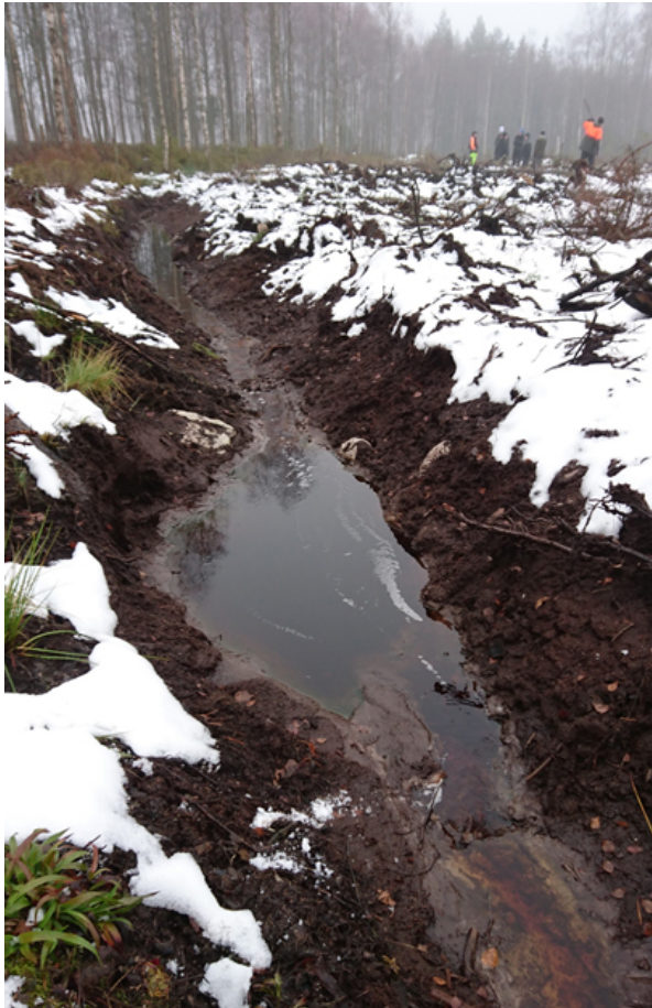
4. attēls. Sedimentācijas bedrītes meliorācijas grāvjos Zviedrijas dienvidu daļā. Foto: Eva Ring (pa kreisi) un Anja Lomander (pa labi).
