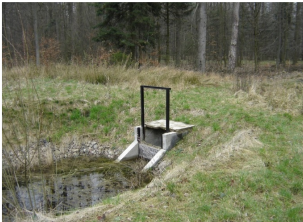
33. attēls. Ūdens noteci no rezervuāriem kontrolējošās hidrauliskās struktūras. Foto: Michał Wróbel.
