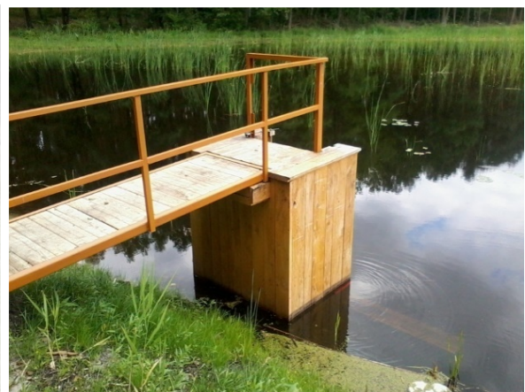
33. attēls. Ūdens noteci no rezervuāriem kontrolējošās hidrauliskās struktūras. Foto: Michał Wróbel.
