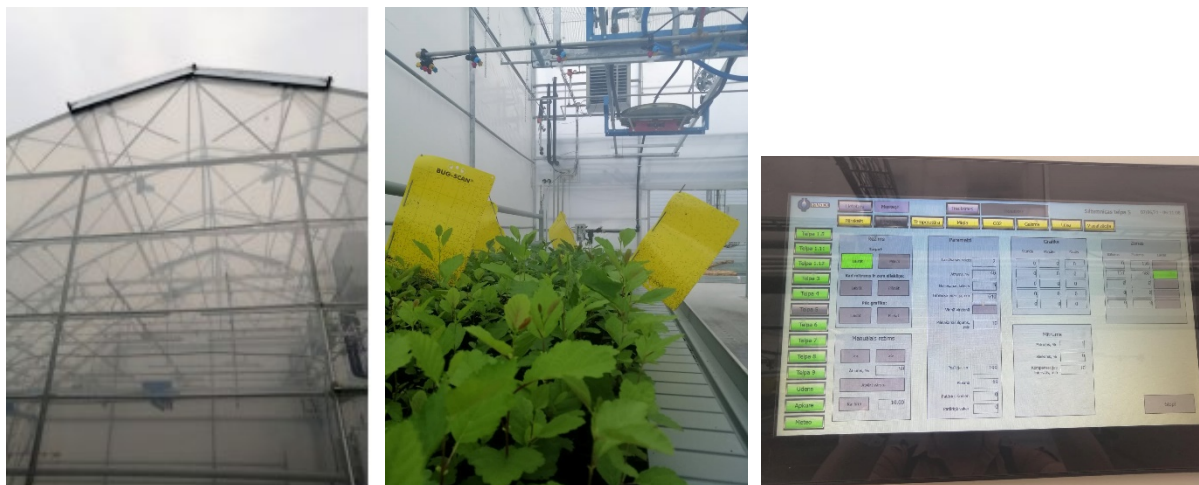
Laboratoriju komplekss ar aprīkojumu laistīšanai, gaisa mitrināšanai, CO2 paaugstināšanai, gaisa dzesēšanai un sildīšanai Meža ielā 2A, Salaspilī
