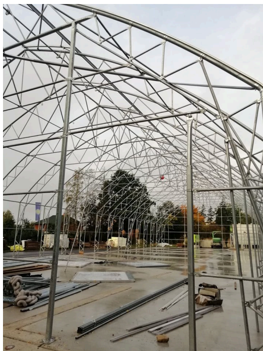
Laboratoriju kompleksa būvniecība Meža ielā 2A, Salaspilī
