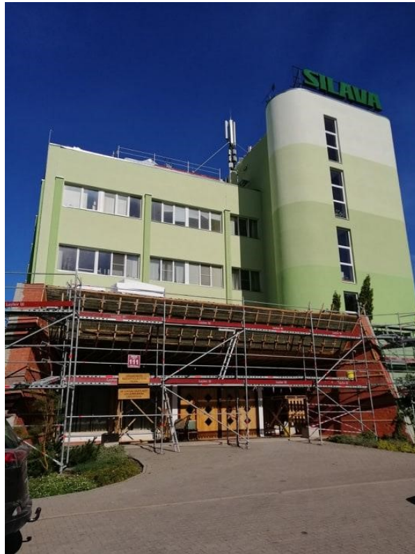
LVMI Silava centrālās ēkas fasādes vienkāršota atjaunošana
