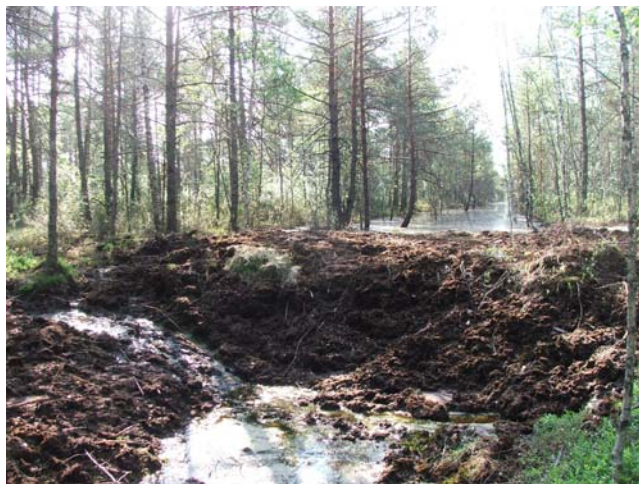
5.3.attēls. No kūdras veidots dambis kontūrgrāvim Cenas tīrelī (foto A. Indriksons).
