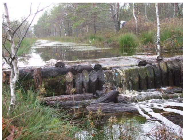
5.4.attēls. Koka baļķu dambis no augstā purva izejošam grāvim Lubānas mitrājā (foto: A. Indriksons).
