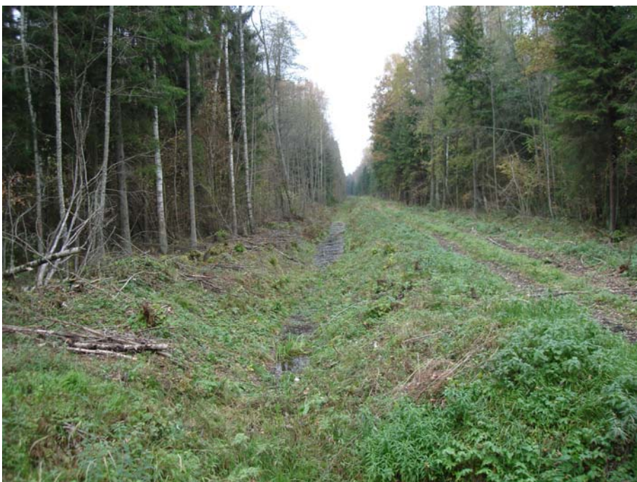
11. att. Ar Bracke C16a izkopta grāvju trase.
