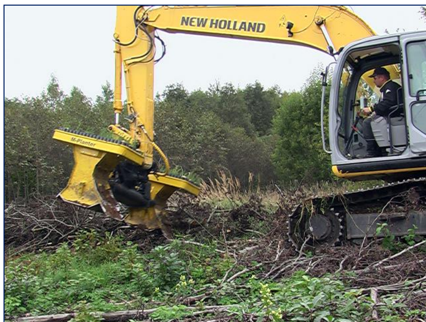
1.1. att. M-planter uz kāpurķēžu ekskavatora bāzes.
